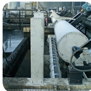
Съёмный лоток и вал для сепарации масла
