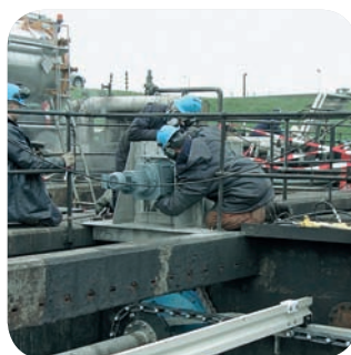
Монтаж сепаратора стандарта API
