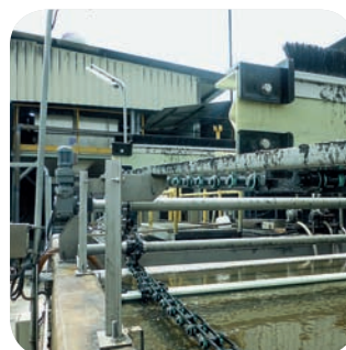
Илоскребы DAF на предприятии нефтехимической промышленности
