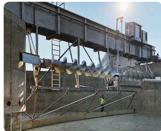
Zgraniacz radialny z systemem odciągania kożucha ściekowego
